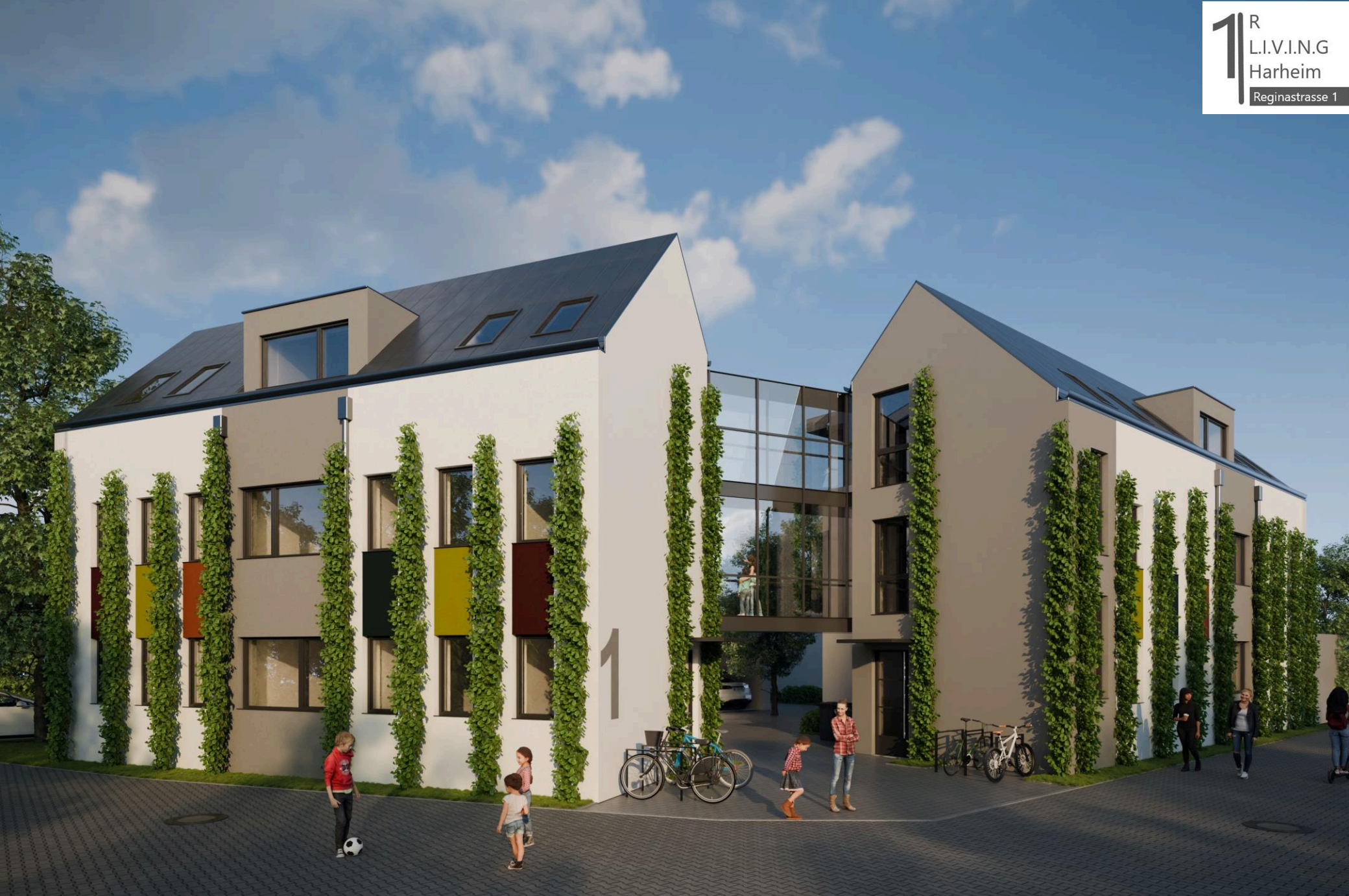
VISUALISIERUNG 2 - AUSSENANSICHT STRASSESEITIG
